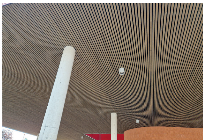
I det nye fellesbygget og de oppgraderte delene av Gudeberg og Prestelandet skole er det utstrakt bruk av spiletak og spilehimlinger i tre.
