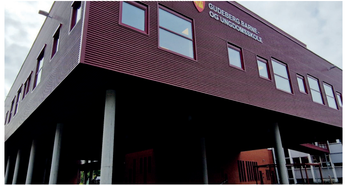
For å unngå at nybygget skulle beslaglegge for mye av det allerede begrensede uteområdet, ble deler av bygget konstruert som en «boks» som hviler på søyler og pilarer over bakken.
