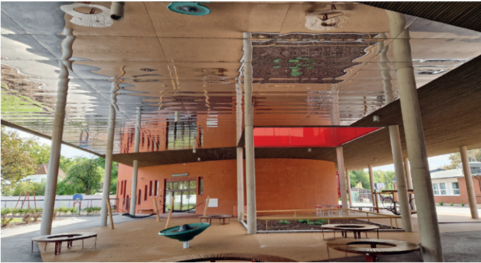
For å motvirke at dette overbygde området skulle oppleves mørkt og skyggefullt er det lagt spill i taket å reflektere lyset.
