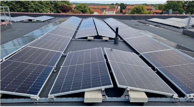
Taket på det 3 700 kvadratmeter store tilbygget er utnyttet maksimalt med solcellepaneler, som har kapasitet til å produsere inntil 130.000 kilowatt strøm i løpet av året.
