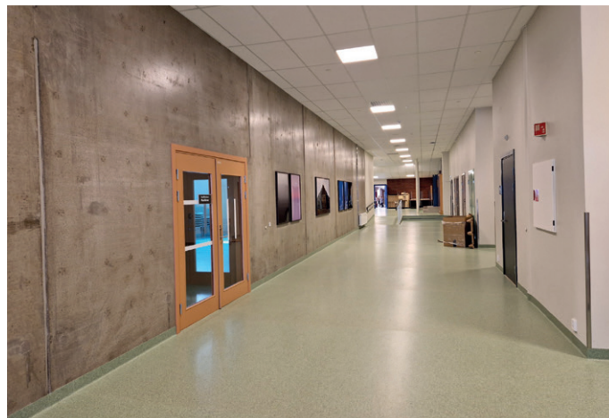
De innvendige veggene er prefabrikkerte, støpt med stålglattet side synlig, støpt i stålform.
